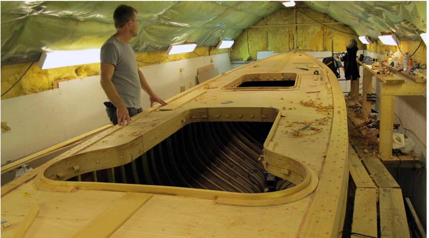
De första två lagren av det nya däck är på plats, det översta lagret av oregon pine ska läggas.
