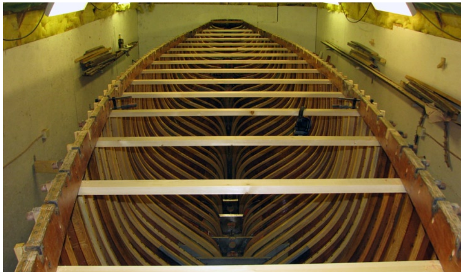
Så här såg det ut när det tidigare däck var borttaget, de ljusa balkarna är tillfälliga stöd för skrovet.
