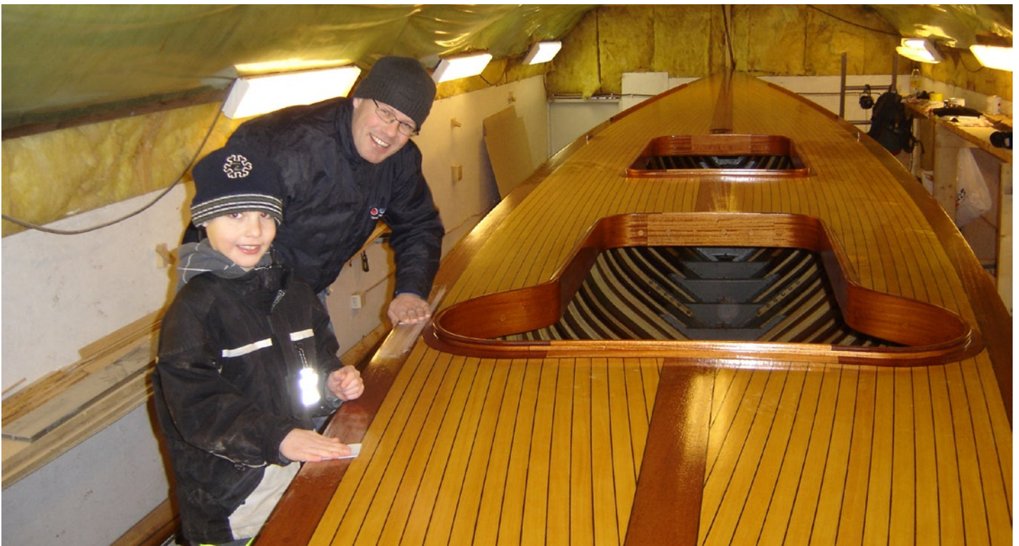
Däcket är lagt och Fredrik får hjälp av sonen Gustav med att matta ned lacken, 8-10 lager ska det bli innan det är klart.
